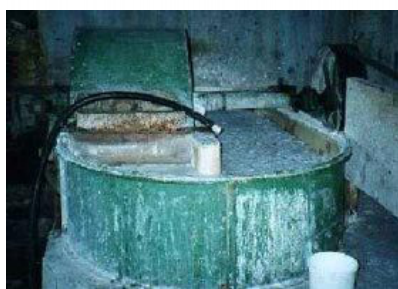
Image 14 Pile hollandaise encore en fonctionnement
