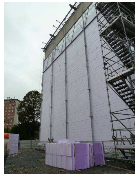
Les blocs de polystyrène extrudés posés
